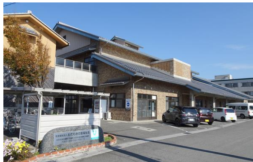
【第1作業所・第2作業所】
